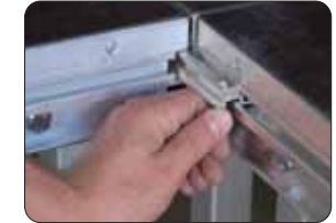
2. MONTAJE DE LOS PIES EN LOS MÓDULOS DE SUELO 2. MUNTATGE DELS PEUS EN ELS MÒDULS DE SÒL
