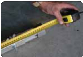
1. REGULACIÓN Y FIJACIÓN PREVIA DE LA ALTURA DE LOS PIES. 1. REGULACIÓ I FIXACIÓ PRÈVIA DE LA ALÇADA DELS PEUS.
