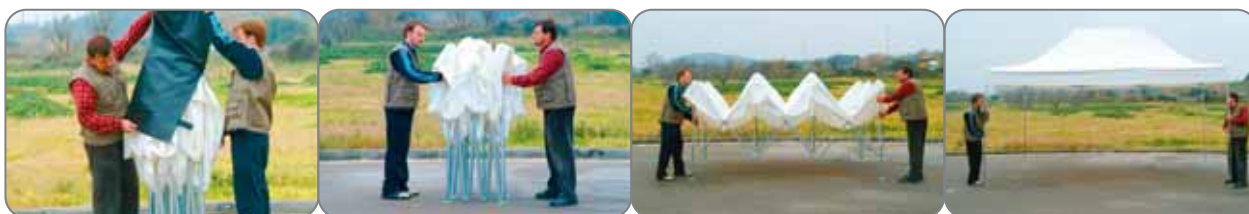
SECUENCIA DE MONTAJE DE LA CARPA SEQÜÈNCIA DE MUNTATGE DE LA CARPA
